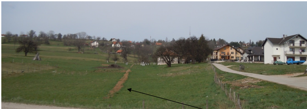
Slika 21 Naselje Stari Baltići (izvedena kanalizacija)
